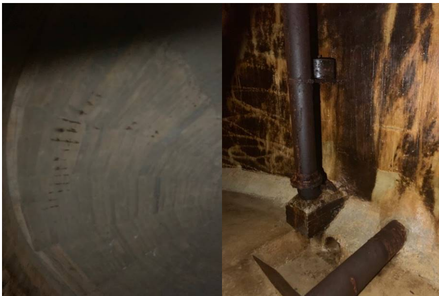
État de la coupole et des conduites intérieures du réservoir
