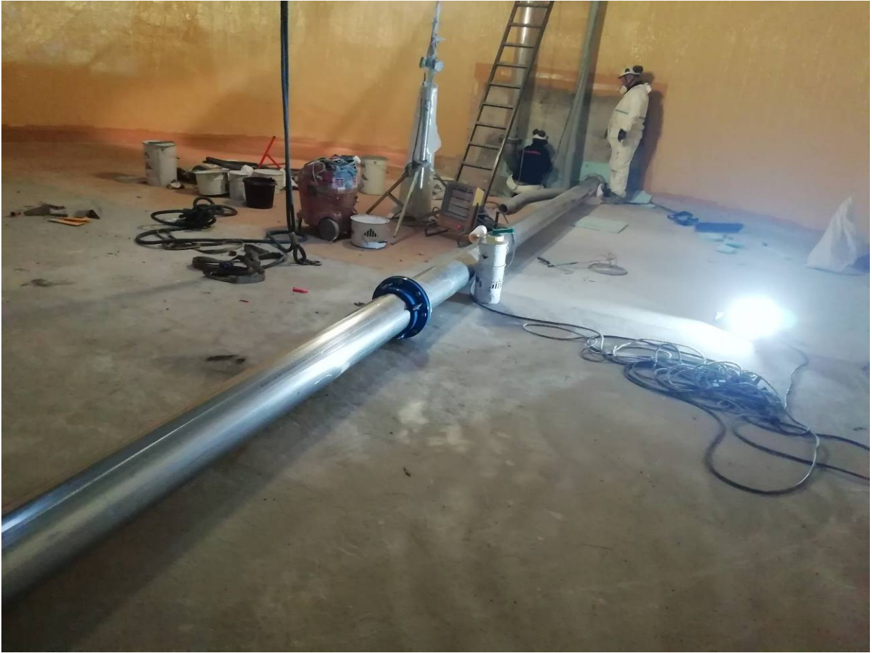
Mise en place des conduites d'alimentation, de distribution et de trop plein
