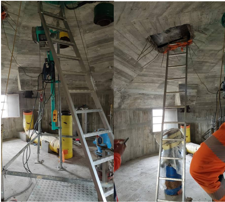
Mise en place moyen de levage et création d'une trappe d'accès provisoire à la cuve
