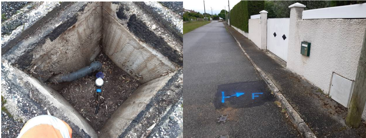
Détection et réparation d'une fuite sur Beaumont-lès-Valence Allée des Gentianes
