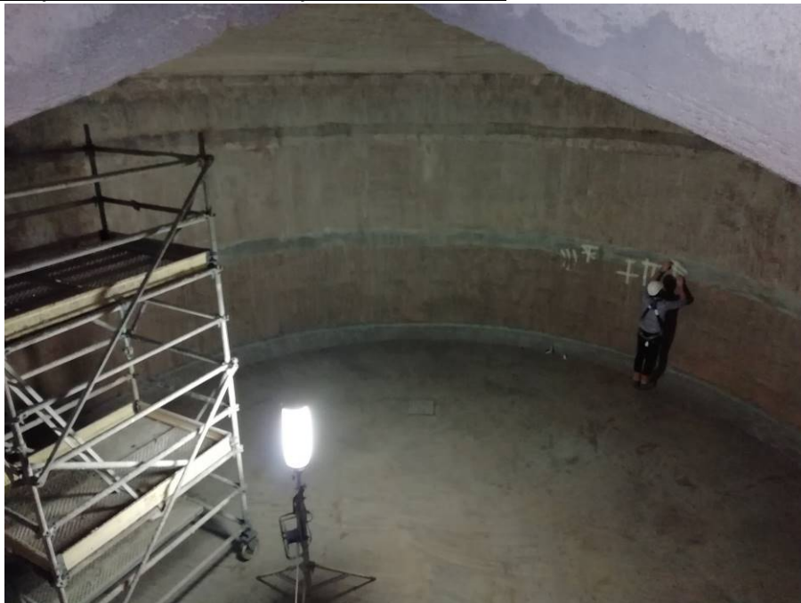
Test d'adhérence avant travaux
