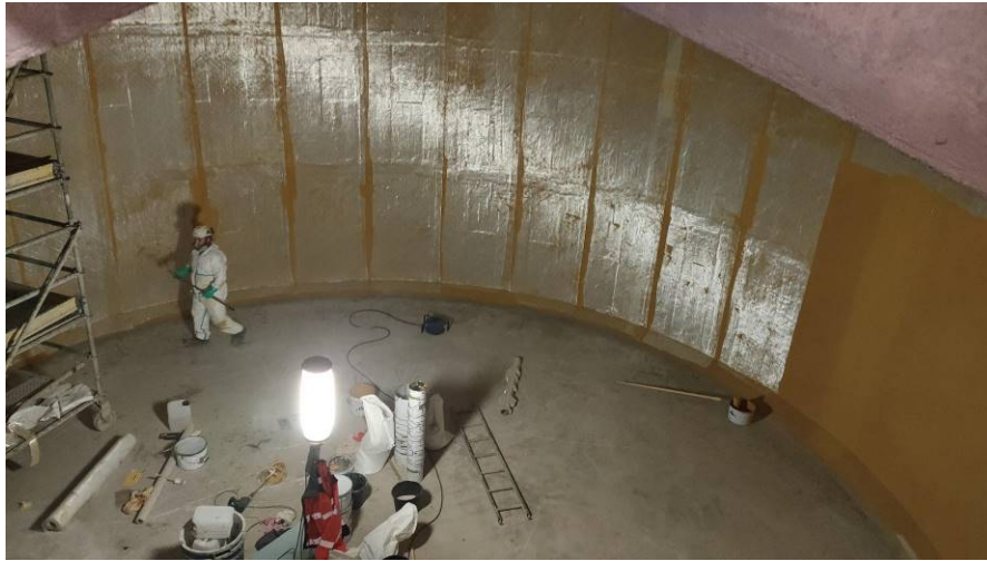
Pose de l'étanchéité
