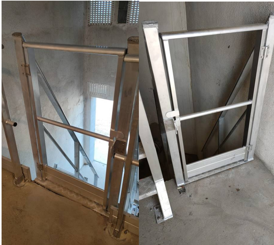
Mise en place de nouveaux portillons et de nouvelles échelles d'accès
