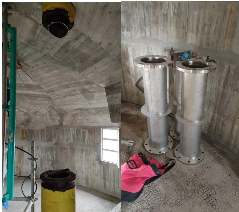
Découpe des anciennes conduites et préparation des traversées de parois
