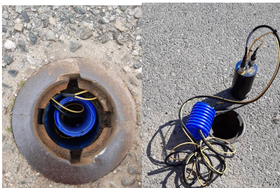
Installation des capteurs du des robinets de prise en charge
