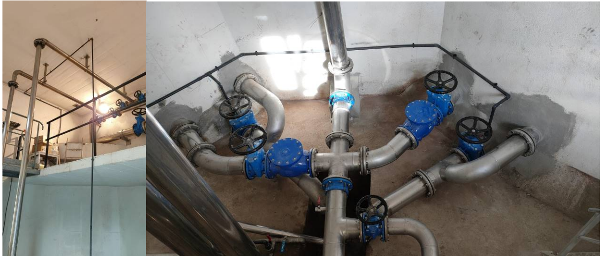
Mise en place des conduites dans la chambre de vannes
