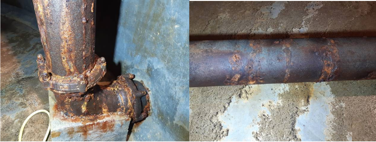
s et équipements à l'intérieur du réservoir très corrodés
