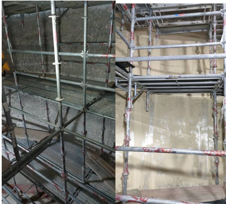
Mise en place des échafaudages dans la cuve
