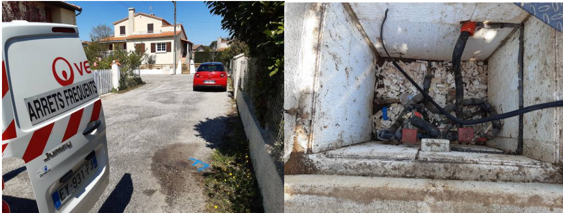
Détection et réparation d'une fuite sur Beaumont-lès-Valence Rue Odette Malossane
