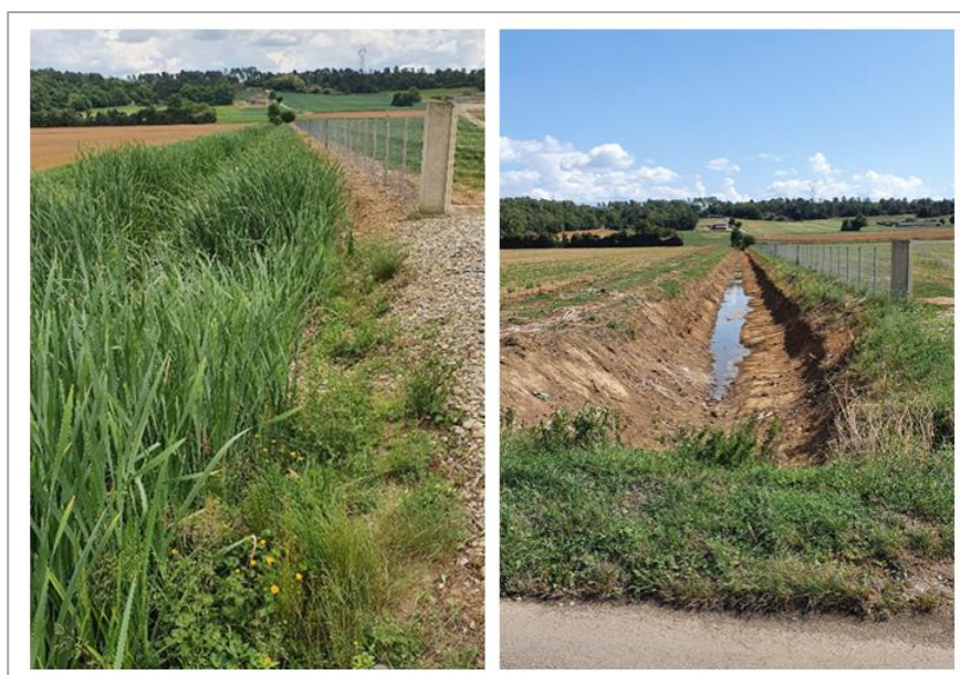
Figure 18 Fossé de Francillon avant curage (gauche) et après (droite) curage
