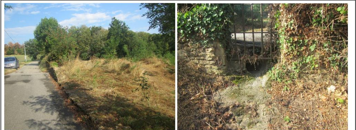
Figure 1 : Mur délimitant le fossé longeant la route du cimetière à Beauvallon et buse d'alimentation amont
