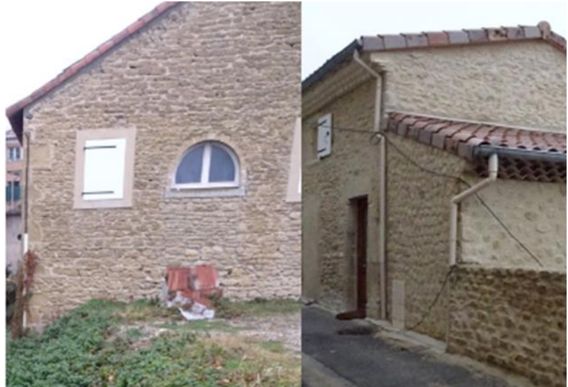
Photographies 59 - Construction traditionnelle (Eco-Stratégie 08/12/2017)
