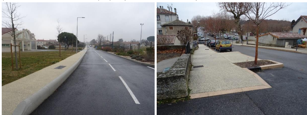
Photographies 14 – Trottoirs sécurisés rue du stade et montée du château (Eco-Stratégie 08/12/2017)
