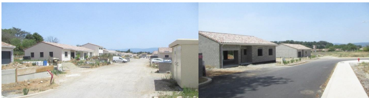
Photographie 17 - Récentes constructions du secteur "Les Gamelles" : Ug1 partie nord à gauche, et partie sud à droite (source : ECO-STRATEGIE, le 16/06/2022)
